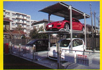
地下2段地上1段昇降式スライド型ゲート
