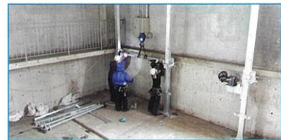
解体後組み立て工事中
