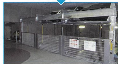
柱・梁も溶融亜鉛メッキ仕様で工事完成
