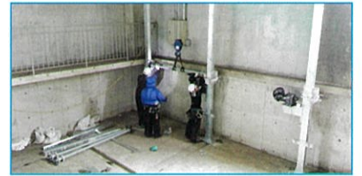
解体後組み立て工事中
