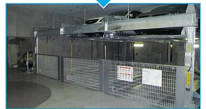
柱・梁も溶融亜鉛メッキ仕様で工事完成
