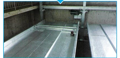
防錆に優れた溶融亜鉛メッキのパレット搬入
