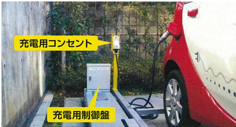
昇降式の立駐機には、全パレットに充電コンセントが取り付けられます。
