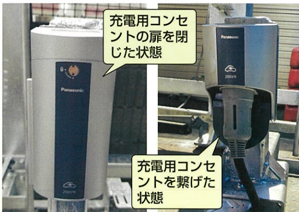
昇降式の立駐機には、全パレットに充電コンセントが取り付けられます。
